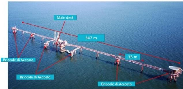
Figura 4-2 – Struttura del Piattaforma offshore PETRA esistente
